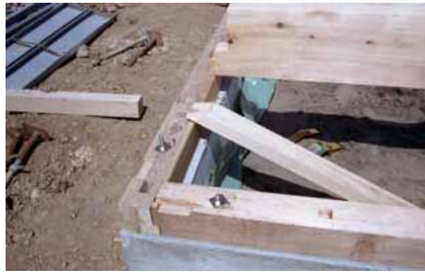
図 1-6 アンカーボルトによる土台の緊結
